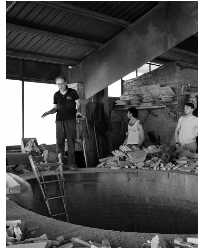
Marco's historic furnace La fornace storica di Marco
