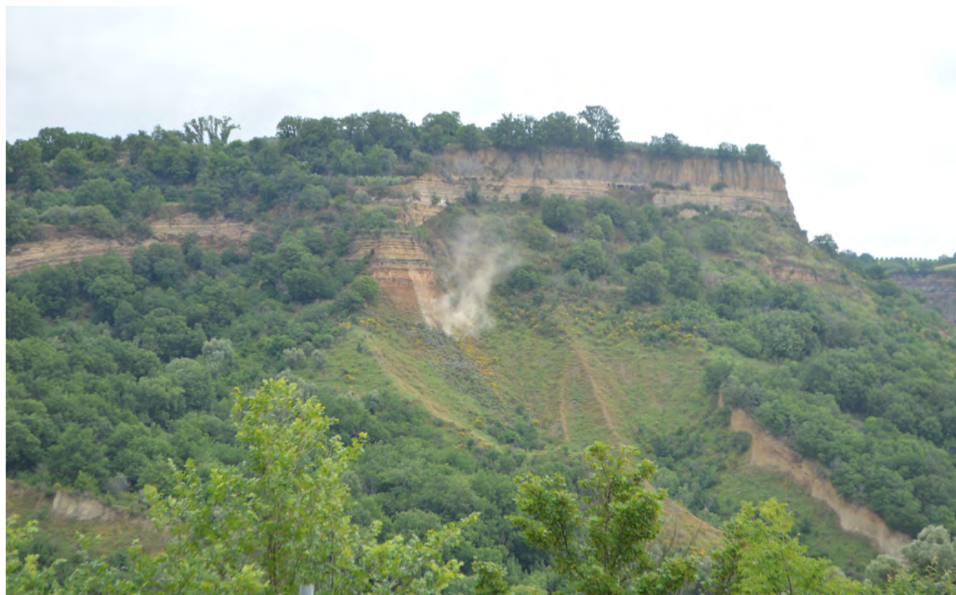
Minor Landslide Frana minore
